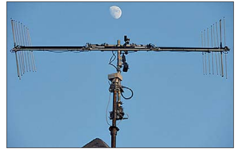
Innerhalb kurzer Zeit kann DD0VF die Yagi-Antennen von horizontaler in vertikale Position drehen. Bei Radio-Aurora hilft dies zwar eher nicht – bei EME-Funk mitunter jedoch sehr. Fotos: DD0VF (2)
